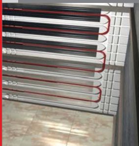
3 Sistema di riscaldamento e raffreddamento a parete radiante
